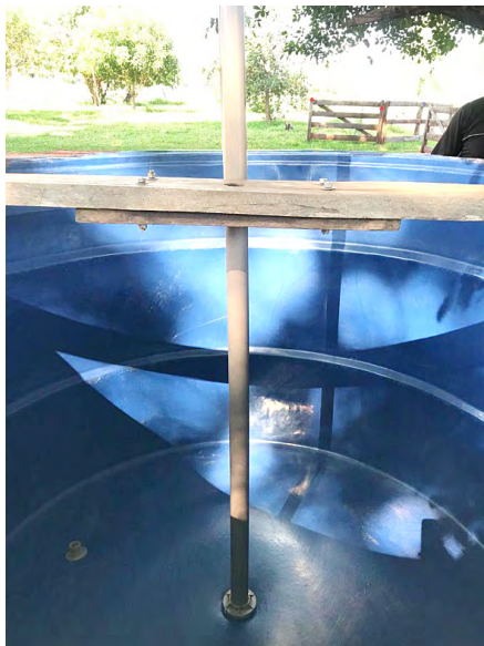
Figura 43: Colocação da tábua na caixa d'água.
