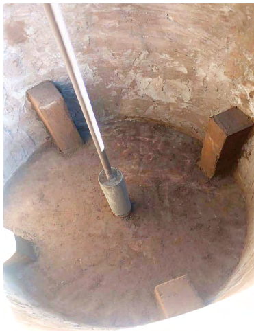
Figura 34 e 35: Tanque de Fermentação, parte interna e externa, após ser rebocado
