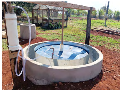
Figuras 52 e 53: Vista de filtro do biodigestor.
