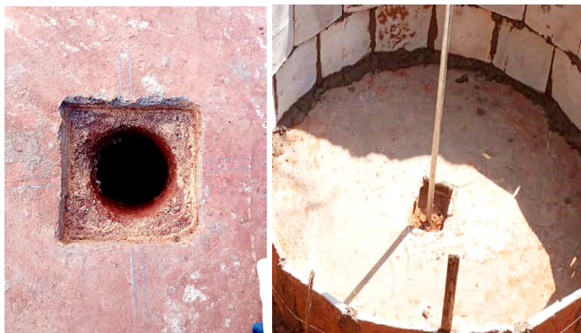
Figura 25 e 26: Colocação do cano guia
