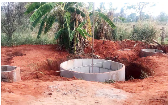
Figura 36: Caixa de entrada e de saída com o desnível da borda do tanque de fermentação.
