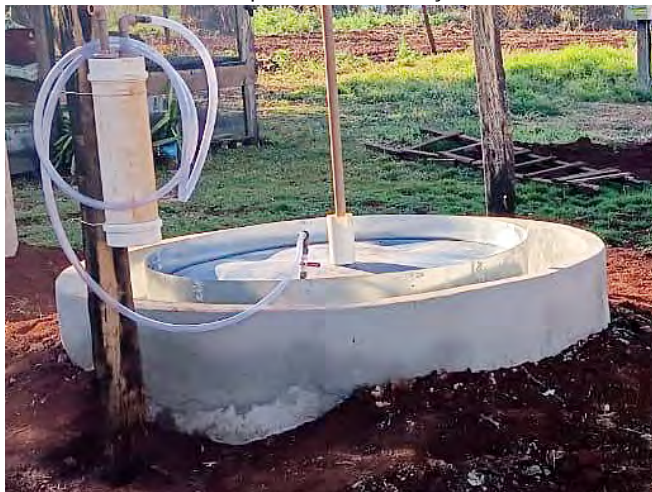
Figuras 47: Câmara de Armazenamento do biogás já colocada sobre o Tanque de Fermentação.
