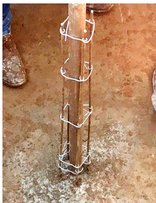
Figuras 27, 28, 29, 30 e 31: Estrutura de instalação e apoio do cano guia.
