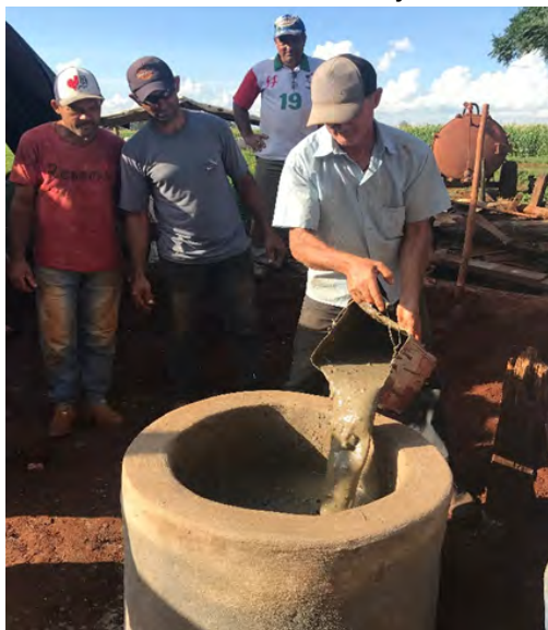
Figuras 31e 32: Utilização de diferentes caixas de carga sendo alimentadas com esterco já diluído.
