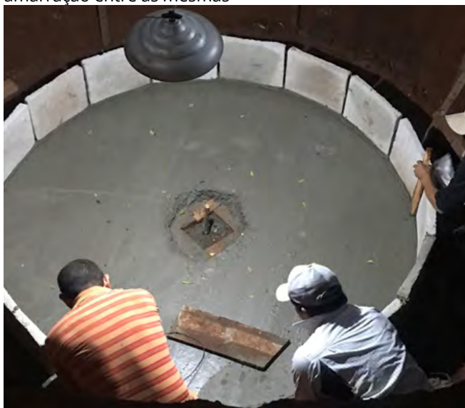
Figura 18, 19, 20 e 21: Etapas de colocação das placas com amarração entre as mesmas
