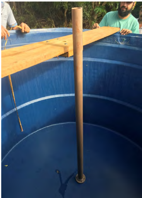
Figura 40: Colocação da tábua na caixa d'água.
