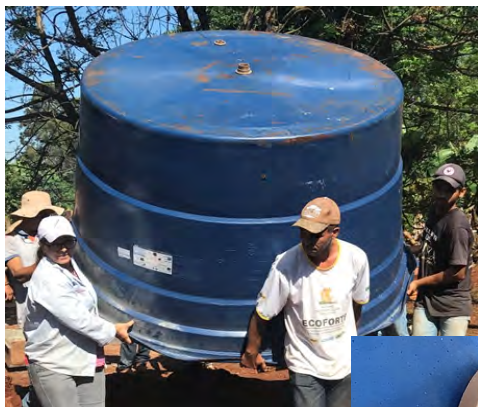
Figura 38 e 39: Caixa d'água de polietileno, construção da Câmara de armazenamento do biogás.
