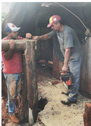
Figuras 48, 49 e 50: Fabricação da trave de segurança
