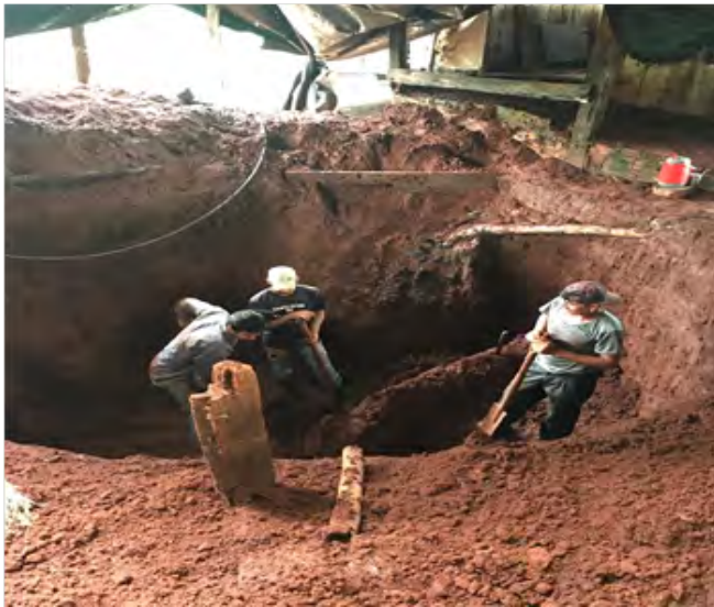
Figura 2: Buraco para construção do biodigestor
