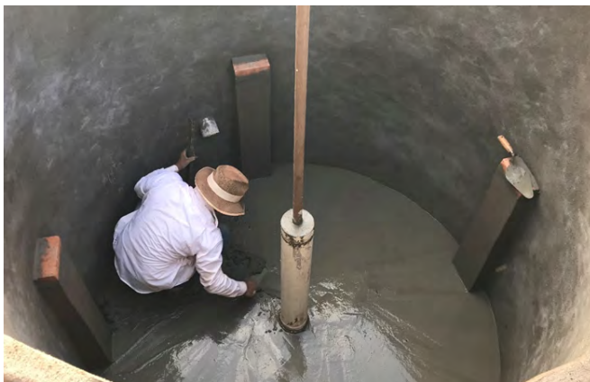
Figura 29: Batentes no tanque de fermentação.
