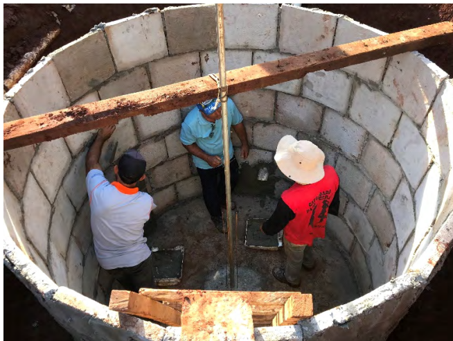
Figura 24: Colocação do cano guia.
