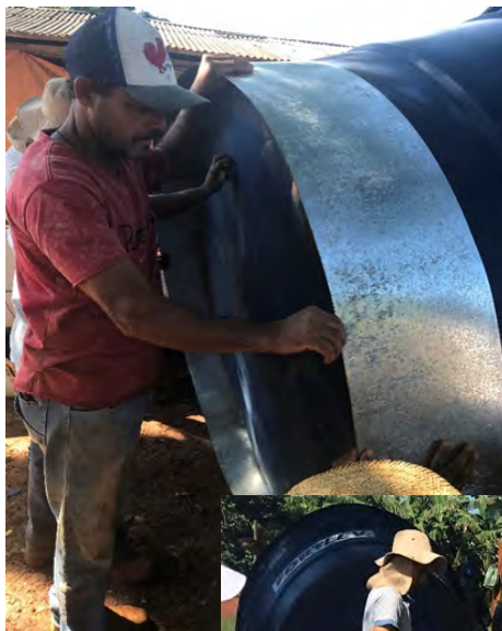
Figuras 43 e 44: Preparo do anel de zinco, acoplado na caixa d'água (Câmara de armazenamento do biogás).
