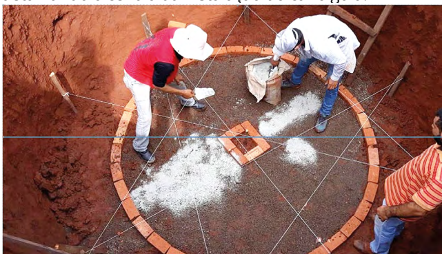
Figuras 14, 15, 16 e 17: Etapas de preparo do piso, detalhando o centro da instalação do cano guia.
