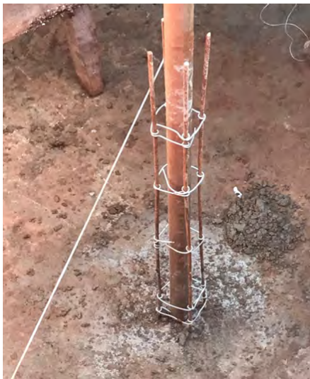
Figuras 25, 26, 27 e 28: Estrutura de instalação e apoio do cano guia.
