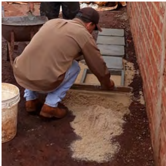
Figuras 6, 7, 8 e 9: Exemplo de como fabricar as placas, atentando para o molde, o preparo e placas prontas
