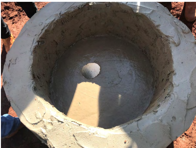
Figura 36: Caixa de carga já rebocada.
