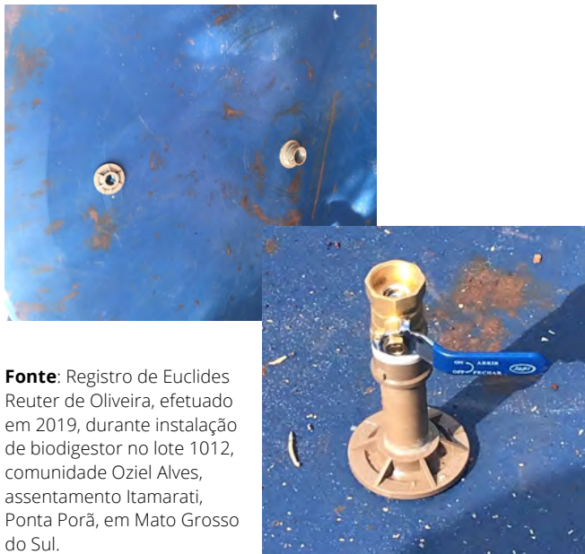
Figuras 41 e 42: Colocação das flanges.
