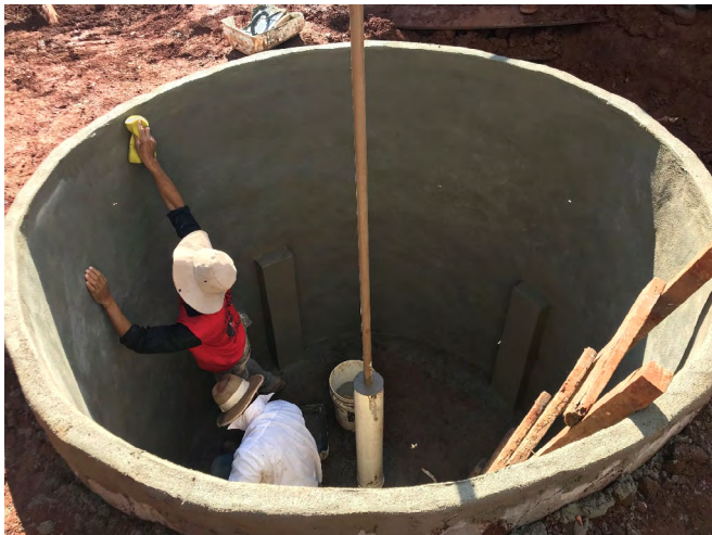
Figura 30: Tanque de Fermentação após ser rebocado
