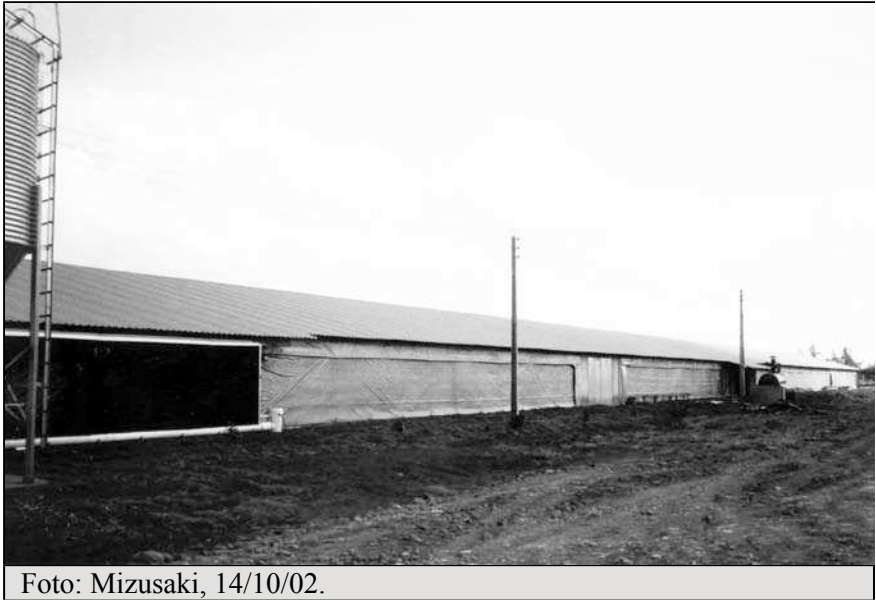
Foto 4 – Parte externa de aviário climatizado
