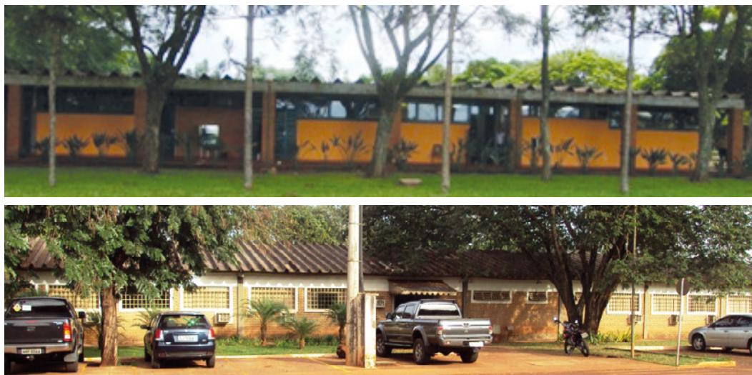
Figura 52 - De cima para baixo, vistas parciais do prédio de administração do NECA/NCA/FCA e do prédio de gabinetes de professores da FCA.
