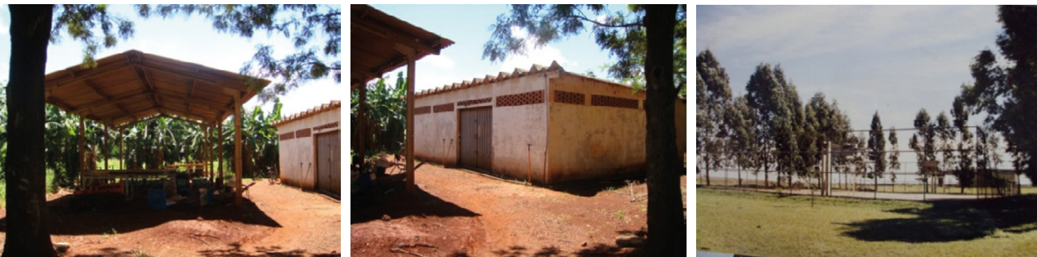
Figura 50 - Construções para apoio das áreas de olericultura e plantas medicinais e antiga quadra de futebol de salão do NECA.
