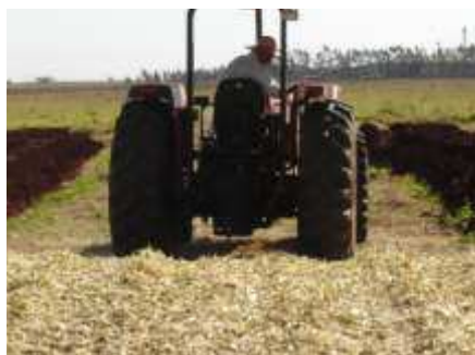
Figura 4: Compactação com trator
